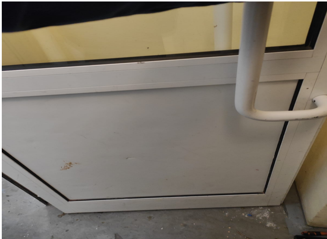
Установка упора двери
