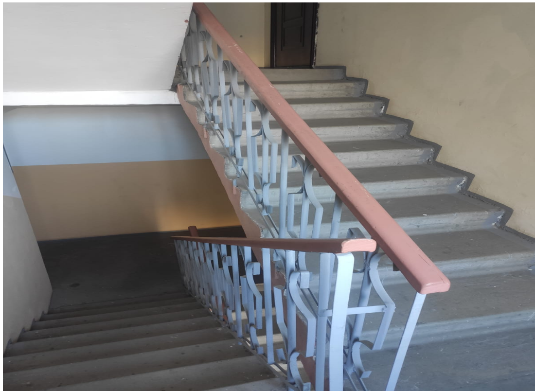
Покраска перил в двух подъездах
